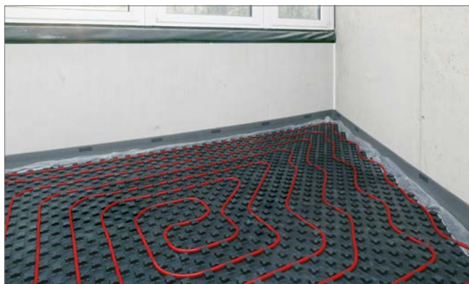
Sl. 4-11 Sistem strana pečurkaste ploče Varionova sa donjom zvučnom izolacijom 30-2
