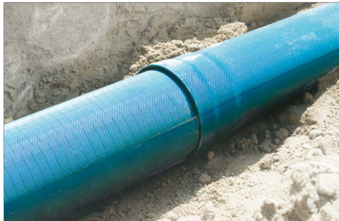
Sl. 13-2 Polaganje drenaže na terenu
