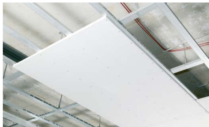
Sl. 5-5 Montiran plafonski element
