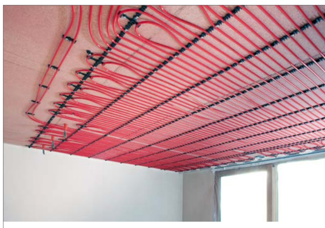
Sl. 5-17 REHAU plafonsko grejanje/hlađenje u mokrom postupku gradnje
