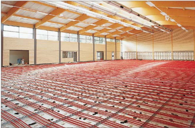
Sl. 11-19 REHAU SBH sistem razdeone cevi
