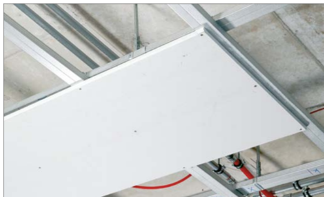
Sl. 5-36 Montiran zidni element na plafonu
