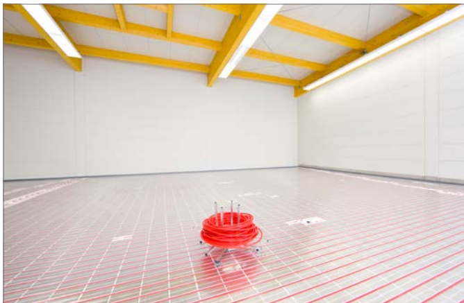
Sl. 11-1 Sistem suve gradnje sa površinsko-elastičnim sportskim podom
